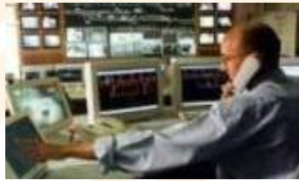
EBI* Screen Puesto de Control Central
